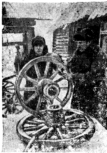
Кузнецы колхоза им. 8 го марта Орехово Зуевского района Московской области Ф. Н. ЛОПАТКИН (слева) и И. В. ЛОПАТКИН ремонтируют с.х. инвентарь.
