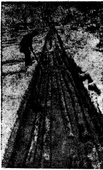
На снимке: Транспортировка леса со склада на лесопильные рамы системой проточных бассейнов (или лотков), с подогретой водой. Этот метод впервые примененный здесь, дал заводу большую экономию, увеличил производительность завода на 50 процентов
