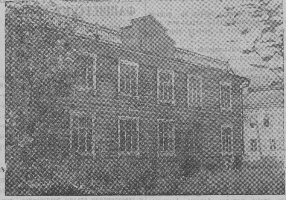
В нынешнем году закончено строительство окружного Дома партпросвещения в Лихославле. НА СНИМКЕ: окружной Дом партийного просвещения. Фото Г. РЕШЕТОВА.
