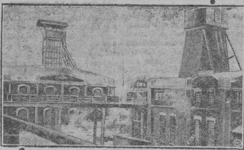
Группа новых строящихся в Донбассе шахт названа „Новый Донбасс“.
