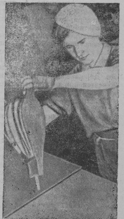
На СНИМКЕ: работница вышневолоцкого зеркального завода П. М. Кирова наливает на стекла жидкое серебро.
