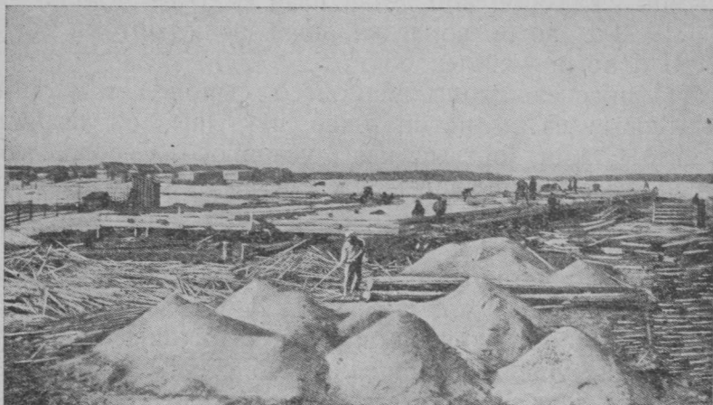
2. еер. Пустыннöј нурјас вылын быдмöны вөр пiлiтан гiгантјас. Кегö-стровса вөрзавод стрöитан ин (Кардорын).
