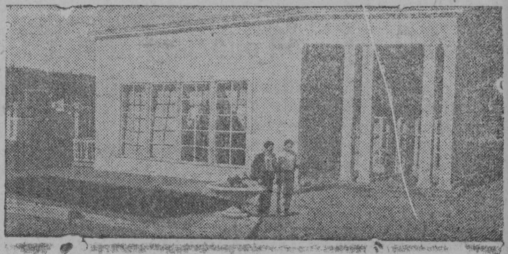
На снимке: Колхозная автоматическая гидроэлектростанция.
