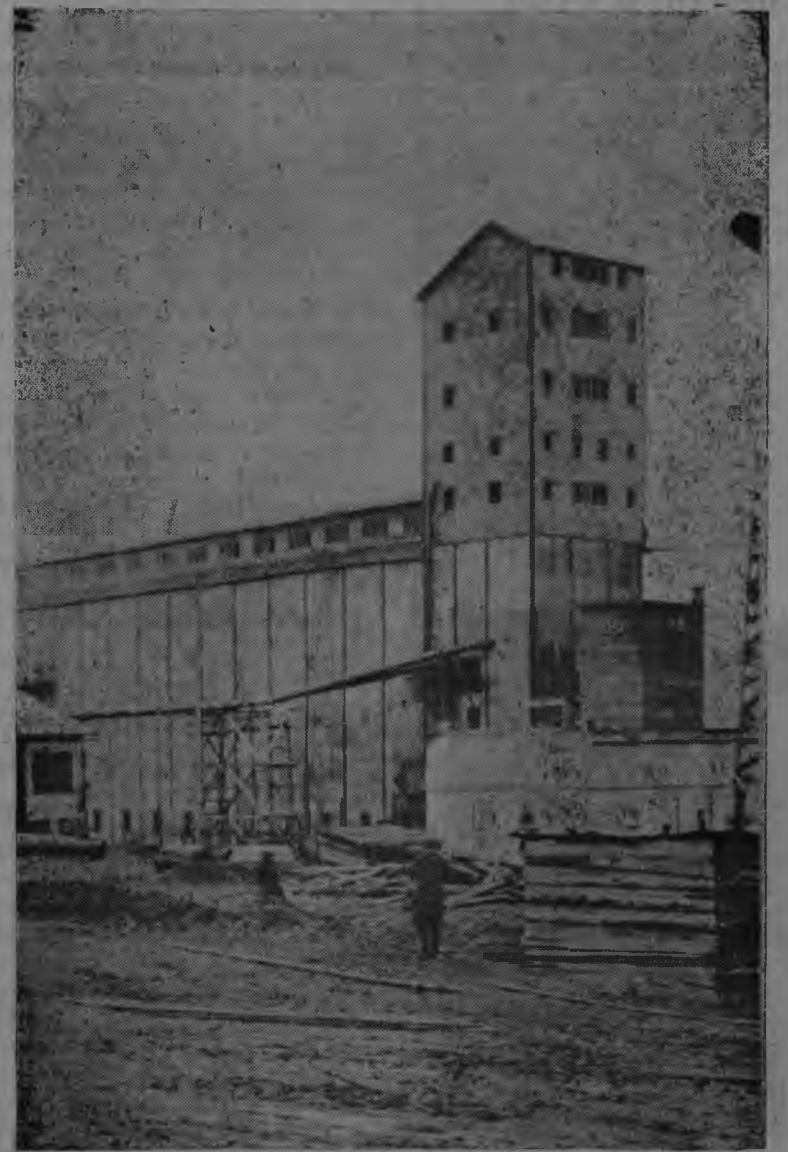
Суред вылын: Кез посёлкысь элеватор. (Кез район УАССР) Солэн емкостез 5 сюрс тонна. Жуждалаез 40 метр. 15 ноябре со эксплуатацие лэземын луоз.
