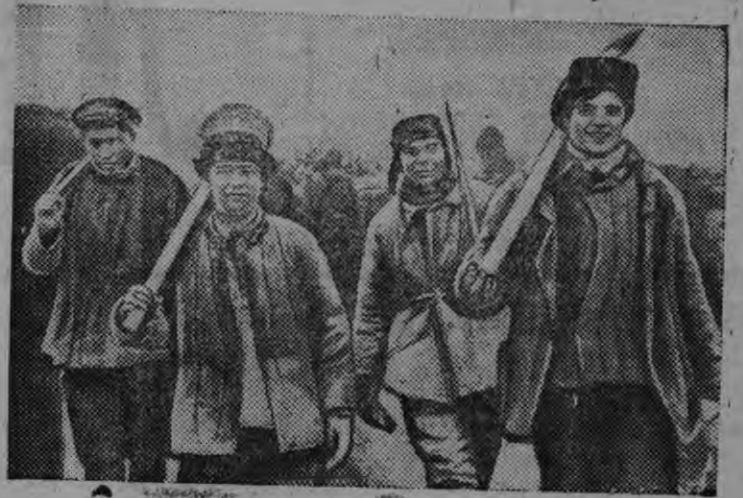
Днепростройсь бетонщик'ёслэн комсомольской бригадазы
