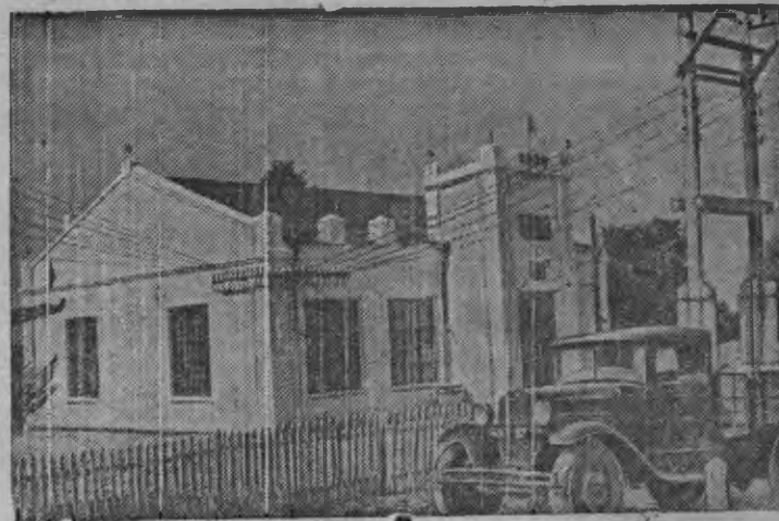
Электростанциялэн общей видэз
