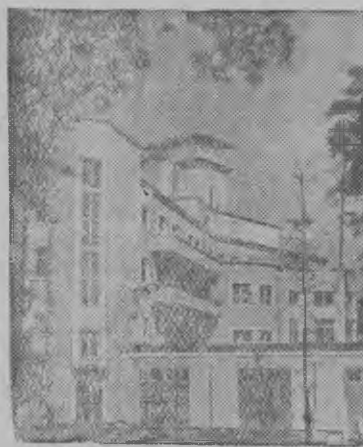
Санаторилэн главной зданиез.
