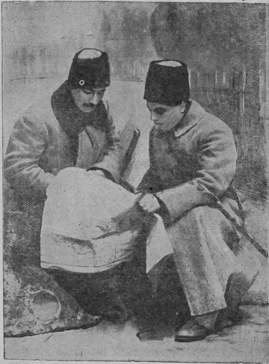
СНИМКАСОНТЬ: К. Е. Ворошилов ды С. М. Буденный 1-це Конной армиясонть Ростов-На-Дону ошонть освобождениядо мейле.
