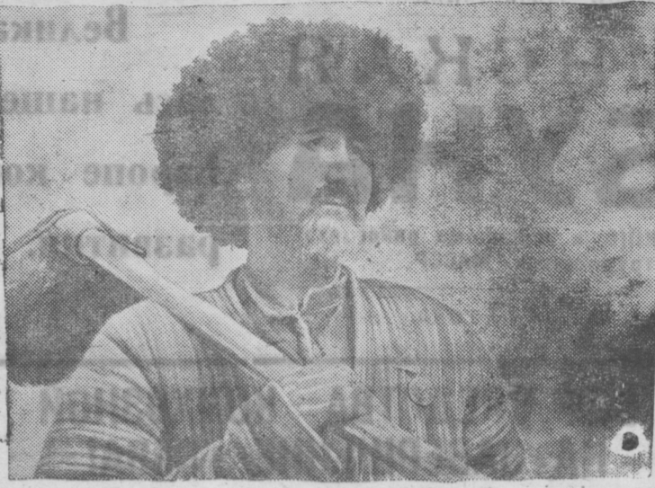
67-летний Балтобой Парманов. За строительство Большого Ферганского канала он награжден медалью „За трудовое отличие“.
