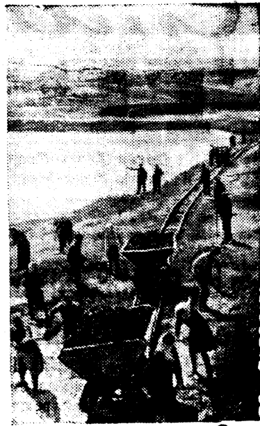
Иренинградская область. В Новоржевском районе широко развернулось строительство прудов и водоемов. Большую плотину сооружают колхозы «Червоный прапор» и имени 2-й пятилетки. Эта плотина позволит создать пруд в водной поверхности в 17 гектаров.
