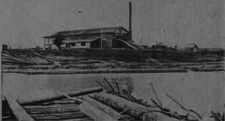
Сыктывдін карса вөр-пільтан завод да електростантсіја.
