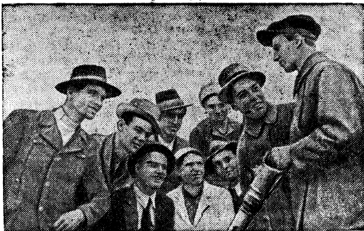
Бригадир навалотбойщиков стахановец шахты № 7 треста „Шекиноуголь“ Ф. А. Сычев (справа), выполняющий норму на 160—170 процентов, знакомит прибывших из Бессарабии товарищей с устройством отбойного молотка.
