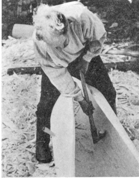
Kuva 26. Lopputelsouksessa veistetään ohuita lastuja. Ahlainen. Valok. E. Nikkilä.
