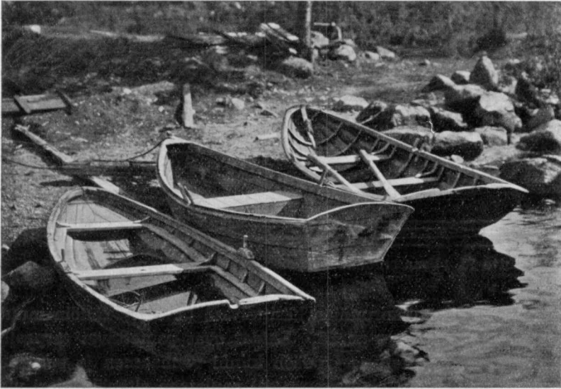
Kuva 78. Kaksi meriruuhua ja keskellä tasapohjainen vannasruuhi. Pyhämaa.
