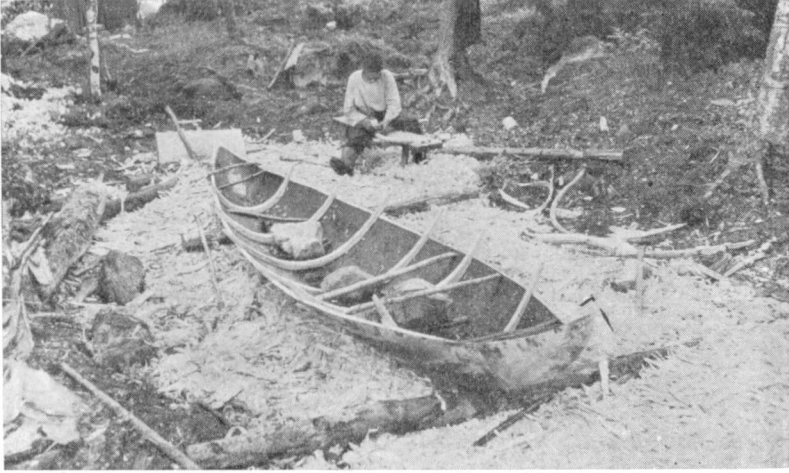
Kuva 30. Kaaret asetettuina paikoilleen. Ahlainen. Valok. E. Nikkilä.
