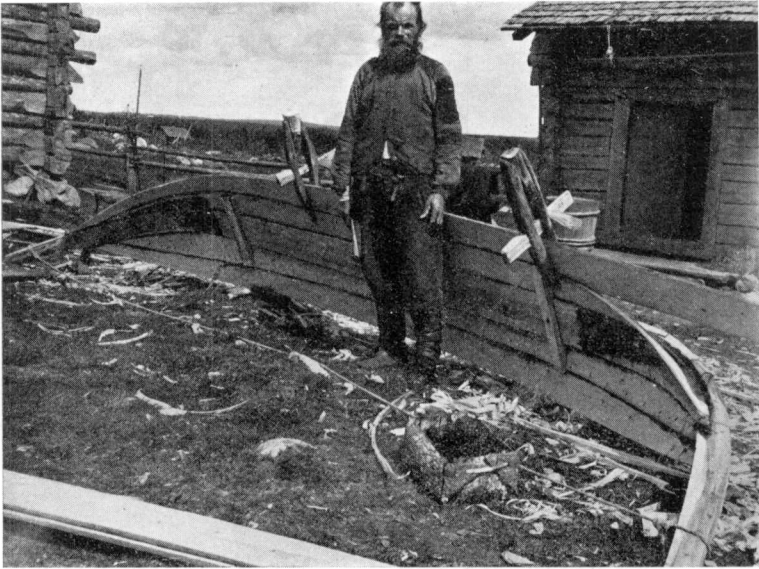
4. 4-laitainen vene tekeillä. Laita on puristettu paikoilleen kahdella salvatsimella . — Etualalla koskutroveh , jossa on laitojen limeihin käytettävää tervaa. — Liusvaara. Valok. K. Vilkuna.
