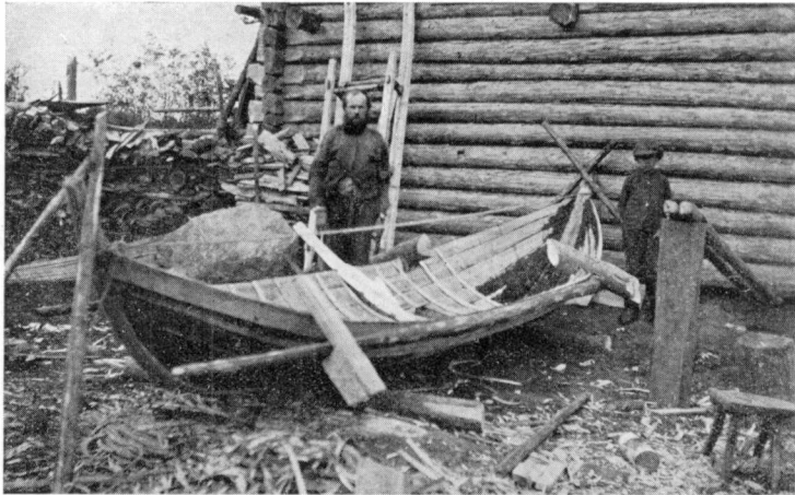
5. Venettä vannotetaan. Vannotuspuut jännitetty hammaspuiden avulla. Oikealla parraspuut painumassa, päät pistettynä seinän alle. — Liusvaara. Valok. K. Vilkuna.
