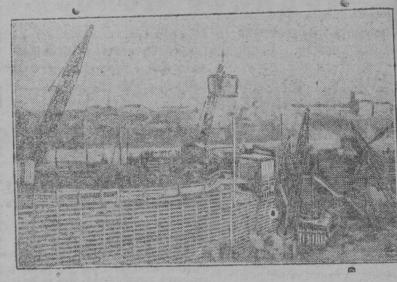
Сильный наводок этого года может создать угрозу отдельным учас строитесьства. В связи с этим ведутся предупредительные работ НА СНИМКЕ: подача под'емным краном бетона для укреплен секционной перемычки на правом берегу Днепра.
