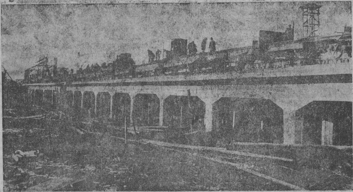
Магнитогорскайсая тийф погрузочно-разгрузочная работа механизированная эстакада.
