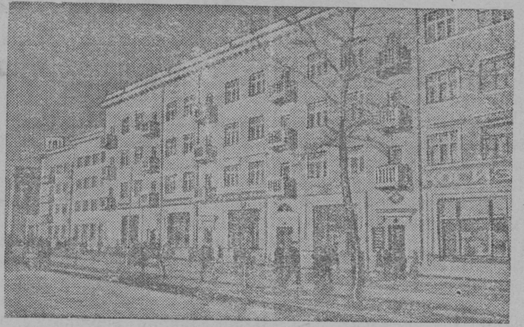
Новый дом на улице Культуры в г. Горьком. Фото П. Вознесенского. Фото-Клише ТАСС.
