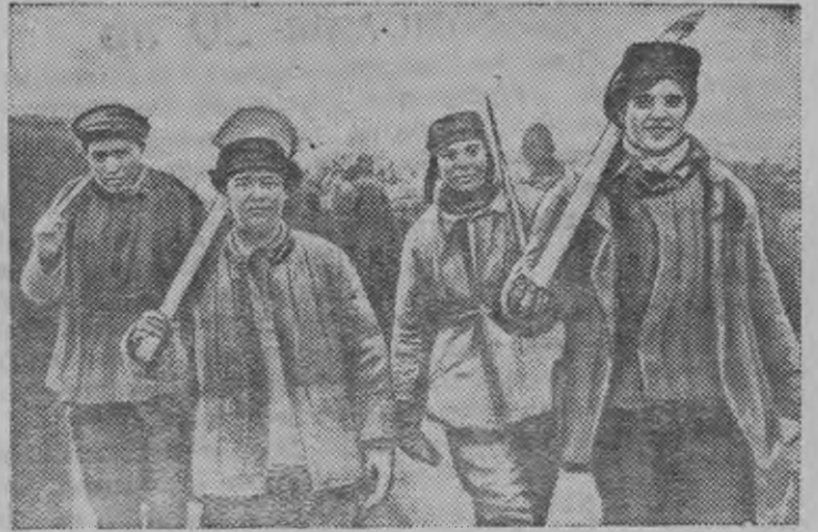
Днепростройын бетонщик'ёслэн комсомольской бригадазы
