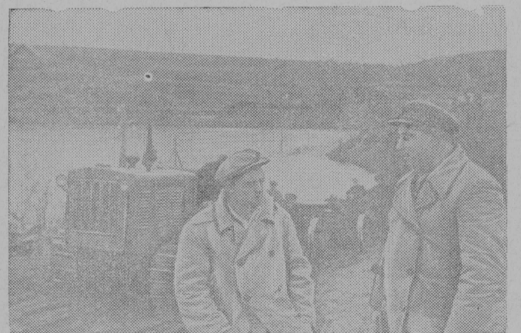
На строительстве земляной плотины на реке Крымза.
