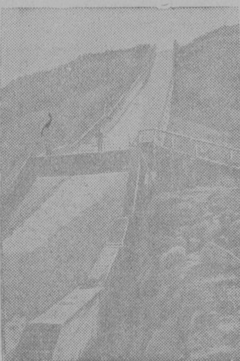
Вдоль русла реки Занги (Армянская ССР), строится ряд гидростанций. На снимке: Законченный строительство быстроток.
