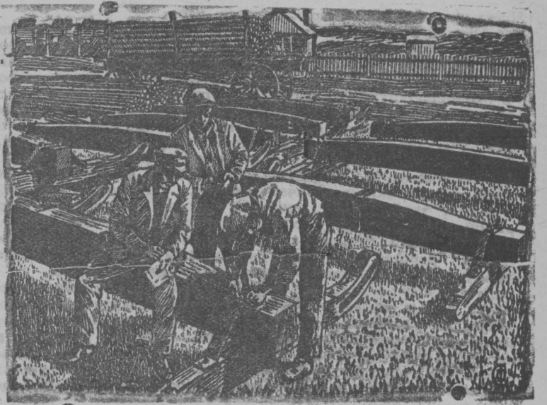
НА СНИМКЕ: Ремонт подвижного состава
