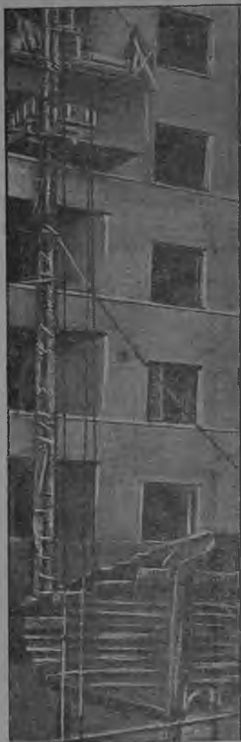
2-шы рис. Лүктәш машина (подйөмный кыран.) кәрәл йатажышкы каркам лүктә. Бункәрәи тугәи вәйләл кай- мыжы.
