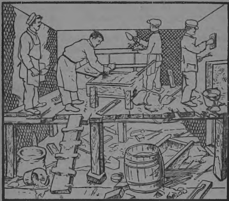
7-шы рис. ЦИТ-влән пәшә бштэймбей вәр. Тәвә ик кышкышэй цитовэц лыгымым кышкә, вэсыжы төрлән мий.
