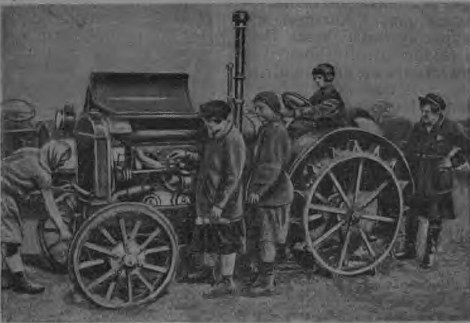
Ровоташ кэмй анцыц пытёрли моторым колтымыла. Тэвэ тракторист ручкам кычэн, кызыйт тэвэ күшкылă сэрэл колта, моторэт ровотайаш тынгэлэш. Малын? Ти ручка кольэнчатый валым сэрэлэшт, тэнгэлэн гынь, кулачковый валат сэрнэлтэш, клапанэт пачылты, цильиндрыш кырасин прак пырэн кэн, кырасинэт пижын пыдэшт кэн, поршынъ шыкэлт кэн, тыйдын паштэкши кольэнчатый вал бишкэок сэрнэш тынгэлэн моторым тэвэ кыцэ колтат **ПУСКОВОЙ РУКОЙАТКА ДОН.**
